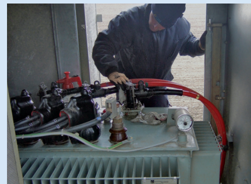
Wartungsarbeiten am Transformator
