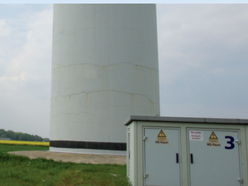
Transformatorhaus an Windenergieanlage
